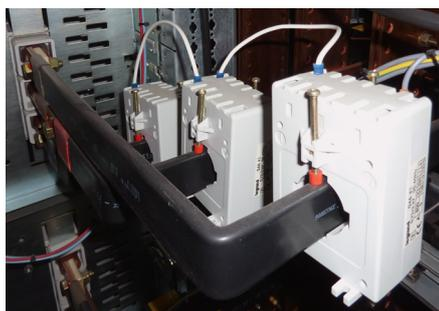
Transformateurs de courant (TC) montés directement sur les barres souples
