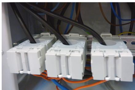
Transformateurs de courant (TC) pour câbles montés sur rail DIN
