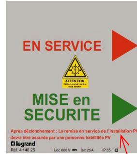
**EN SERVICE** → la poignée de manœuvre en position haute, le sectionneur est fermé, les panneaux produisent du courant vers l'onduleur.
