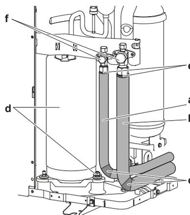
6 Si l'unité extérieure est installée au-dessus de l'unité intérieure, couvrez les vannes d'arrêt (f, voir ci-dessus) avec le matériau d'étanchéité pour éviter l'eau condensée sur les vannes d'arrêt se déplace vers l'unité intérieure.
