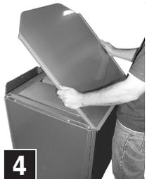
4 Fixer le panneau de décoration sur le dessus de l'unité à l'aide des vis appropriées. Si un ballon d'eau chaude sanitaire (en option) est installé, se reporter au manuel d'installation du ballon d'eau chaude sanitaire.
