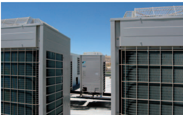
VRV® RÉVERSIBLE AVEC RACCORDEMENT À DES UNITÉS INTÉRIEURES STYLÉES
