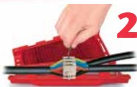
**2** placer les conducteurs dans le bloc connecteur de la boîte et visser avec la clé Allen
