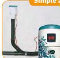
Un simple Té de dérivation suffit pour connecter le boîtier de commande sur le réseau d'aspiration. Ce dernier sera placé juste avant la centrale d'aspiration. Le boîtier positionné, il ne reste plus qu'à connecter les 2 fils d'alimentation sur le circuit de commande basse tension de la centrale. **Lors du montage, utilisez la notice jointe qui vous précise la procédure d'initialisation du système.**
