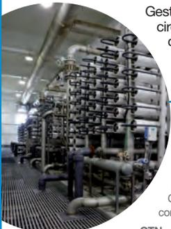
Gestion des pompes de circulation, surveillance du débit, de la pression, de la température de l'eau osmosée...
