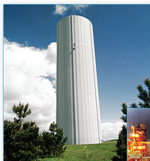
Traitement de l'eau
