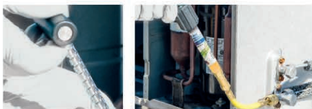
Injection du colorant en tournant la poignée.
