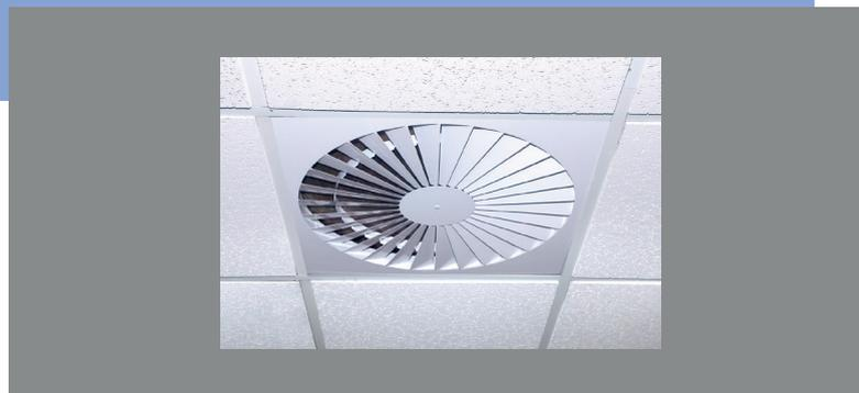
Les diffuseurs de la série RXO ont été conçus pour une utilisation dans les installations de ventilation, de chauffage et d'air conditionné. La conception des lames du diffuseur et leur disposition circulaire insufflent l'air en lui donnant un mouvement circulaire avec un effet coanda, ce qui amène à un taux d'induction élevé tout en réduisant la stratification.
