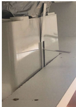
Positionnement des clips de fixation
