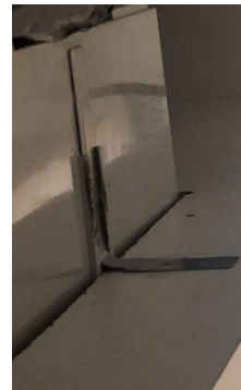
Enfoncer les clips pour fixation du plénum
