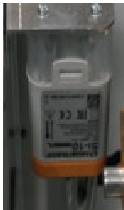
Illustration de la pompe à condensat intégrée en usine (option).
