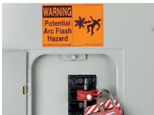
Señalamientos de Seguridad
