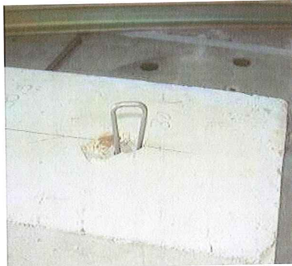
Photo 6.1 : Crochet Gripple installé dans le support
