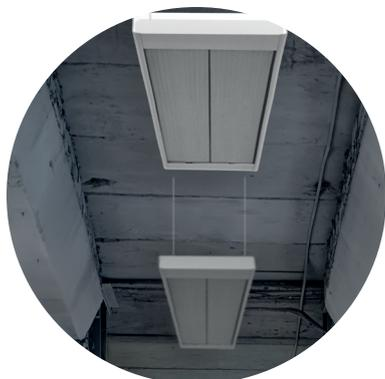
Dans l'exemple suivant, la demande du client était de maintenir une température ambiante correcte dans le hall d'exposition d'une concession de voitures. Les appareils devant être installés à une hauteur supérieure à 3 mètres pour respecter la réglementation en vigueur dans les ERP.
