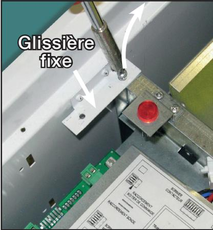
Retirer les deux vis de fixation du bloc de ventilation.
