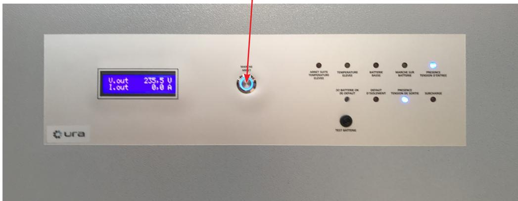
8- Vérifier le bon fonctionnement du contrôleur d'isolement de la source (voyant vert) et vérifier l'écran
