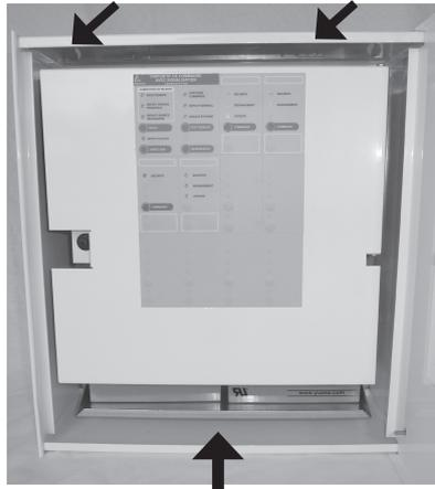
Engager le capot dans les encoches en haut du socle et la vis en bas du socle.
