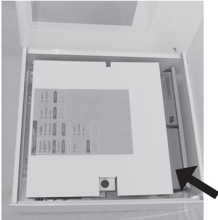
Ouvrir la porte et dévisser la vis sous le bac batteries d'un tour.
