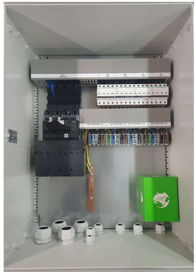
Figure 43 : Photo coffret AC TRI 4 onduleurs sans dif ref 23415043
