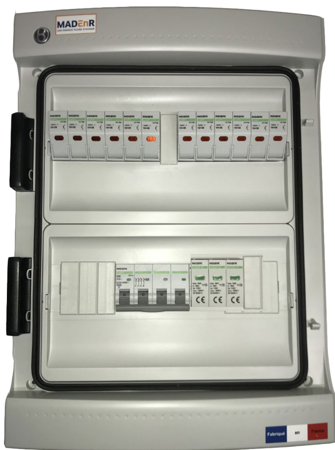
Figure 24 : Photo 1MPP + fusibles 1000V PVF6-1050 ref 11016121
