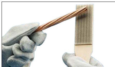
Fig. 12 – Ensuite, utiliser une brosse métallique pour préparer davantage la surface des conducteurs (brosse nVent ERICO T-313 ou T-314). Gratter la surface extérieure pour éliminer la saleté et l'oxydation. Vous remarquerez un léger changement de couleur.
