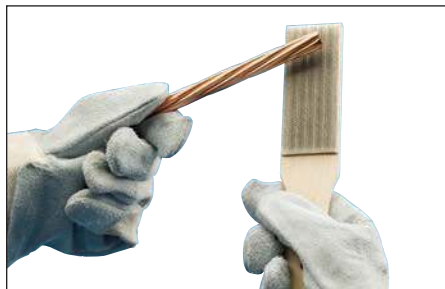
Fig. 12 – Ensuite, utiliser une brosse métallique pour préparer davantage la surface des conducteurs et de la piquet de terre (brosse nVent ERICO T-313 ou T-314). Gratter la surface extérieure pour éliminer la saleté et l'oxydation. Vous remarquerez un léger changement de couleur.
