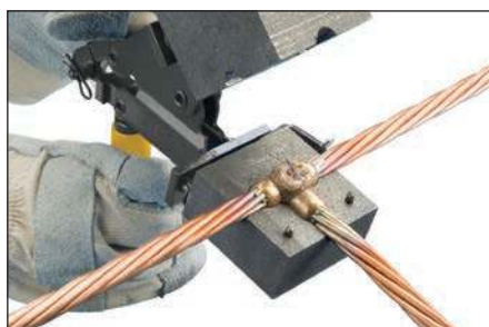
Fig. 25 – Ouvrir le moule et désactiver la connexion. Prendre des précautions pour éviter de broyer le moule. Éviter tout contact avec des matériaux chauds. Voir la section « Normes de qualité nVent ERICO Cadweld » pour voir si une connexion de qualité a été établie.
