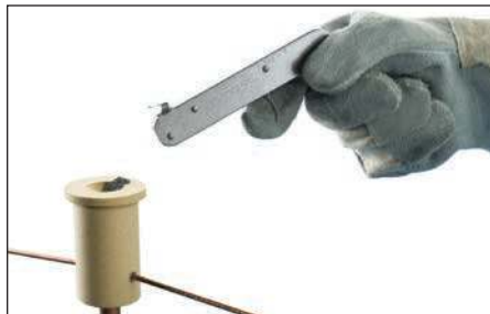
Fig. 15 – Tout en visant l'allumeur à flint sur le côté, enflammer le matériau de départ sur le couvercle du moule. Retirer rapidement l'allumeur pour éviter l'encrassement.
