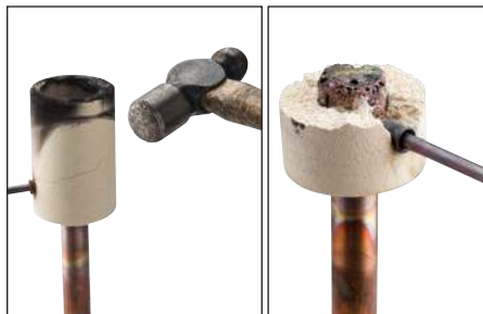
Fig. 15 – Déconnectez le moule Cadweld One Shot en céramique de la connexion. Éviter tout contact avec des matériaux chauds. Voir la section « Normes de qualité nVent ERICO Cadweld » pour voir si une connexion de qualité a été établie.
