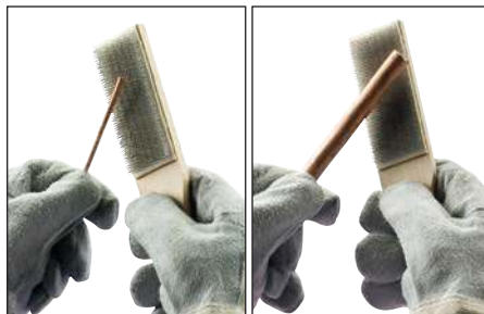
Fig. 5 – Ensuite, utilisez une brosse métallique pour préparer davantage la surface des conducteurs et du piquet de terre (broche T-313 ou T-314 à douille).
