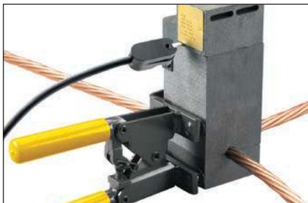
Fig. 19 – Fermer le couvercle du moule en graphite. Informer le personnel à proximité des opérations de soudage dans la zone.
