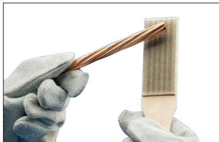
Fig. 12 – Ensuite, utiliser une brosse métallique pour préparer davantage la surface des conducteurs (brosse nVent ERICO T-313 ou T-314). Gratter la surface extérieure pour éliminer la saleté et l'oxydation. Vous remarquerez un léger changement de couleur.
