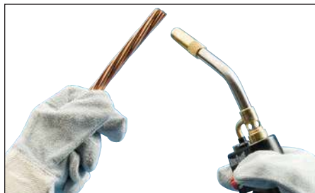
Fig. 11 – Les conducteurs doivent être propres et secs avant d'effectuer la connexion. Utiliser un chalumeau au propane pour sécher les conducteurs métalliques et éliminer les résidus de nettoyage restants, le solvant ou l'eau avant d'effectuer la connexion Cadweld.
