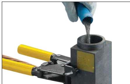
Fig. 21 – Verser la poudre de métal d'apport en vrac dans le moule Cadweld Exolon.
