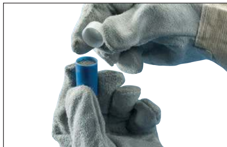
Fig. 10 – Ensuite, prenez le tube du métal d'apport inclus dans l'emballage Cadweld One Shot et retirez le couvercle par-dessus au-dessus du creuset.
