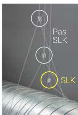
Le verrou SLK peut résister à un angle d'écartement du câble de 90° maximum, le dispositif peut donc être placé au plus près des équipements larges, comme les gaines de ventilation rondes, dissimulant le verrou pour une installation finale plus esthétique.
