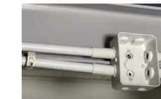
Conduits et boîtier électrique sur poutre acier
