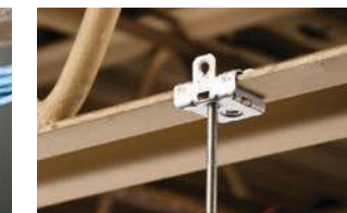
Tige filetée/chaîne/câble sur poutre acier
