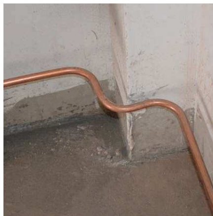
Equipotential grounding conductor
