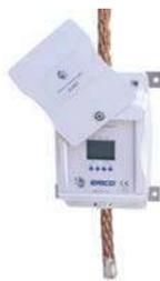
Le conducteur de descente Ericore s'adapte facilement aux structures existantes. Encart : Compteur de coups de foudre nVent ERICO installé pour enregistrer les coups de foudre sur le System 3000.
