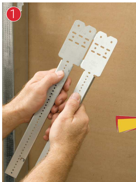
1. Ouvrir la fixation TSGB au point de pliure.
