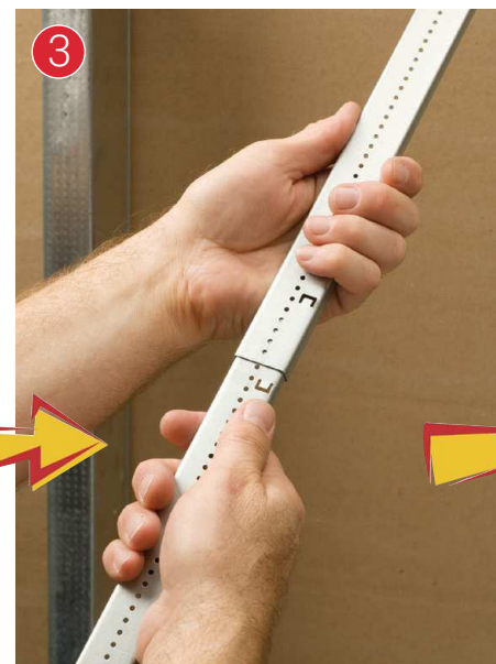
3. Faire coulisser un bras sur le second jusqu'à entendre un bruit de cliquetage.
