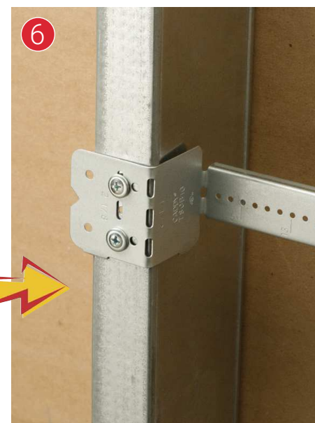
6. Installer la fixation TSGB sur les montants avec les petites vis article no. 187197.
