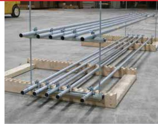
L'espacement des tuyauteries sur le support doit être le même afin que celles-ci puissent être facilement connectées bout à bout. Il est recommandé d'utiliser des gabarits en bois afin de garantir un espacement constant entre tuyauterie et une répétabilité d'un module à l'autre. Ce type de gabarit peut être rapidement fabriqué et customisé sur site ou en atelier à l'aide de morceaux de bois.
