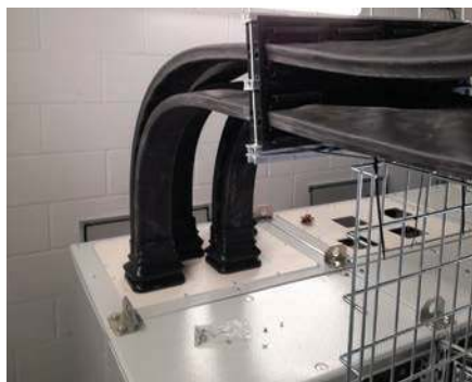
Exemple de découpe individuelle sur plaque amagnétique
