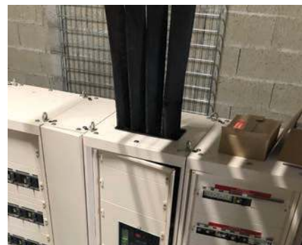
Exemple de découpe globale sur plaque magnétique (acier)
