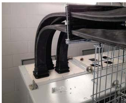
Ejemplo de corte individual en una placa no magnética
