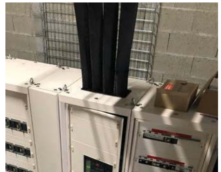
Voorbeeld van globaal uitsnijden op magnetische plaat (staal)
