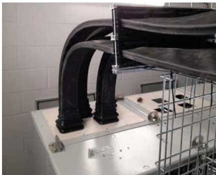
Voorbeeld van individuele uitsnijding op niet-magnetische plaat
