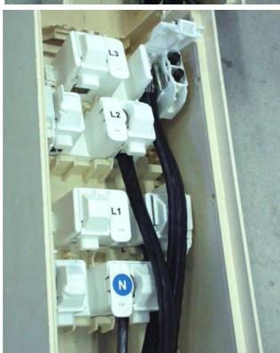
. Effectuer la mise à longueur, dénuder les conducteurs sur une longueur de 45 mm. Former cette partie dénudée pour la mettre parallèle au fond de l'étrier.
