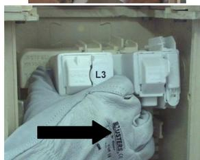
. Mettre en place les modules L1, L2 et L3 en les engageant sous les glissières : pousser jusqu'au clipsage.
