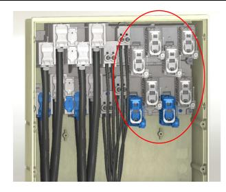
La grille dispose dans sa partie droite de 2 pas REMBT G3. Suivant les références de grille, ceux-ci sont équipés ou non de modules.
