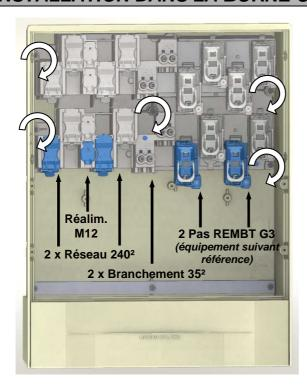
Panneau et surplinhte enlevée, la grille se fixe en fond de cuve en partie haute de la borne par l'intermédiaire de 5 vis.
