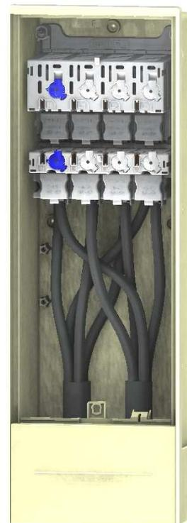
4 – Raccorder les conducteurs du câble de départ en procédant de la même façon que pour le câble d'arrivée (voir ci-contre).
