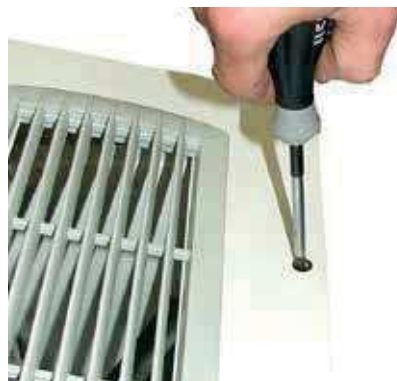
Dévisser la vis de fixation.
