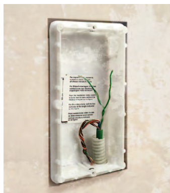
Utilisation d'une paire de fils existants pour connecter la nouvelle platine de rue
