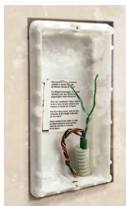
Utilisation d'une paire de fils existants pour connecter la nouvelle platine de rue
