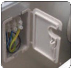
Trappe électrique accessible + schéma
