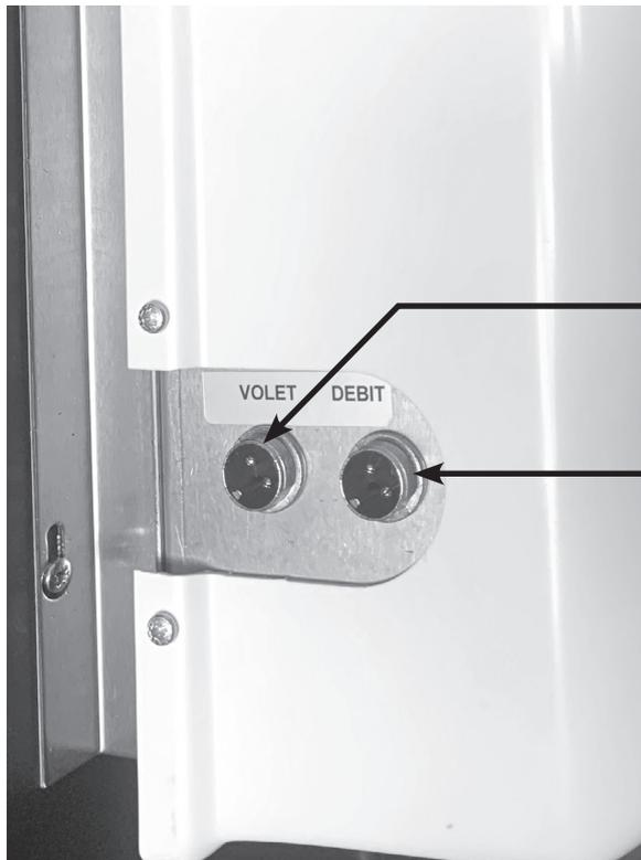
Acometida del cable para la cubierta. Se trata de un contacto seco que activa la función *slow mode* cuando se cierra la cubierta.
