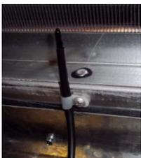
Fixer cette sonde à l'aide de l'attache en plastique fourni. Elle doit être placée sur le débit d'air de retour (Avant le mélange avec l'air Froid). S'assurer que le bulbe en résine de la sonde ne soit pas recouvert par le tuyau de protection en vinyle. Dans le cas d'un groupement de batteries DX VRF, les sondes TA doivent être placées ensemble (voir image de droite).
