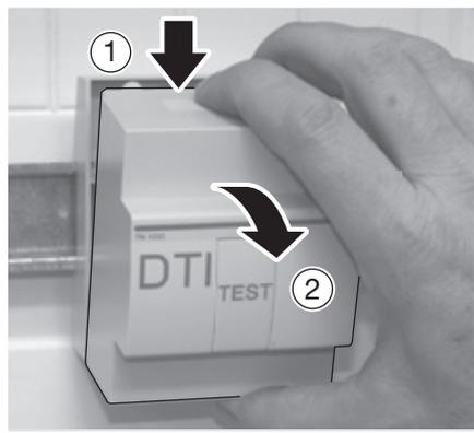
Pour ouvrir le DTI, appuyer sur le haut et le bas du capot et le retirer
