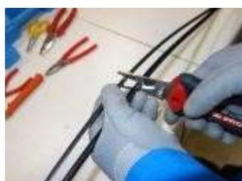
4. Dégager les porteurs à l'aide d'un outil tranchant sur 5 cm.
