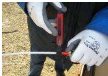
8. Rompre le tube au niveau de l'entaille radiale en pliant légèrement. Attention à ne pas endommager les modules de fibres.
