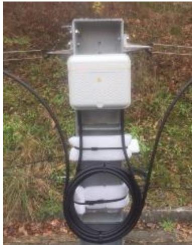
**Note 1 :** Ces loves de blocage produisent un effet cabestan, tout mouvement de l'âme optique à l'intérieur de la structure est supprimé et la force résultante en sortie des loves est quasi nulle.
