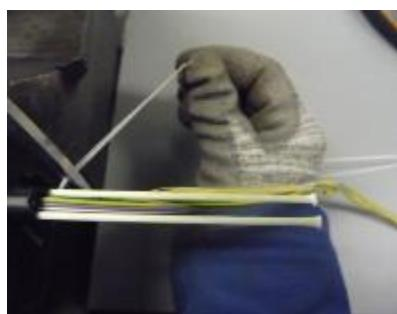
**9.** Préparer les porteurs latéraux et selon la structure, tresser les mèches de renfort en tresses (torsader la mèche de renfort si unique) sur environ 7cm. Poser une largeur de ruban auto vulcanisant en silicone pour l'amarrage sur la platine de la boite de raccordement.
