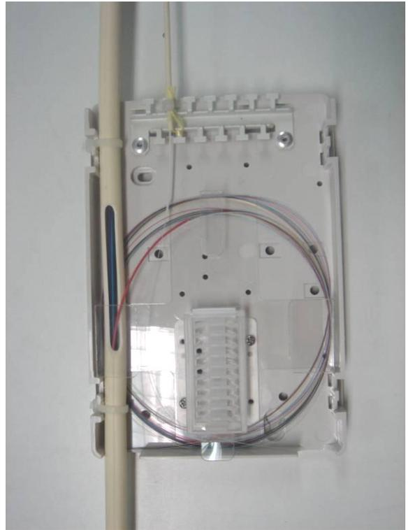
Fixer le câble d'abonné au boîtier après avoir dénudé la fibre sur 1m.
