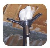
Insérer la boîte dans l'applicateur et bloquez-le en tournant l'axe. Aappuyer l'entier contre le plafond et maintenir ainsi la position de la boîte.
