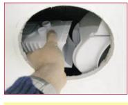
Assembler les deux demi-coquilles à l'intérieur du trou Assembler aussi le porte-transformateur
