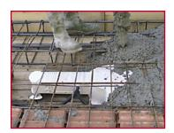
Clouer la boîte au coffrage, au point où le spot à installer sera placé.
