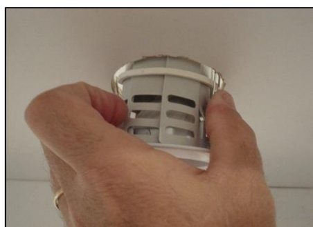
10 – puis la tige métallique, le spot et lâcher les ressorts.
