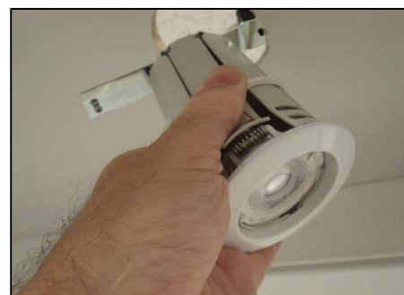
9 – Insérer le boîtier de connexion dans le plafond
