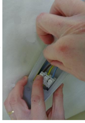
Raccorder au réseau
