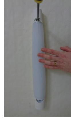
Fixer à travers l'applique et tester l'allumage.
