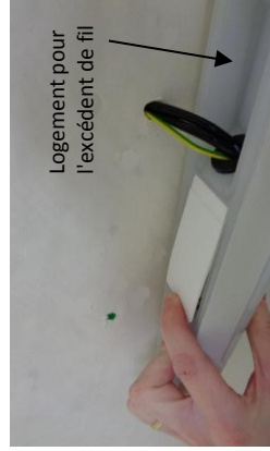
Ouvrir la trappe à l'aide d'un tournevis plat.
