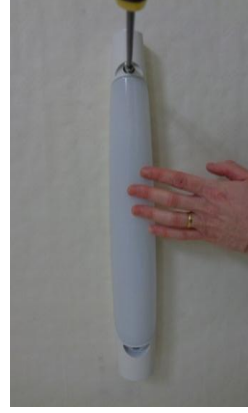
Fixer à travers l'applique et tester l'allumage.
