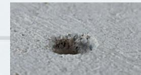
Perçage diamètre 32 Longueur 1 mètre dans béton C50/60.
