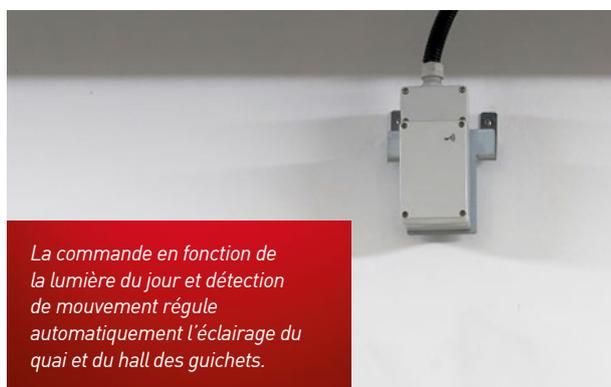
*La commande en fonction de la lumière du jour et détection de mouvement régule automatiquement l'éclairage du quai et du hall des guichets.*
