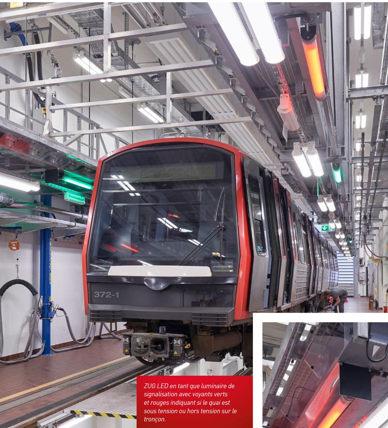
*ZUG LED en tant que luminaire de signalisation avec voyants verts et rouges indiquant si le quai est sous tension ou hors tension sur le tronçon.*
