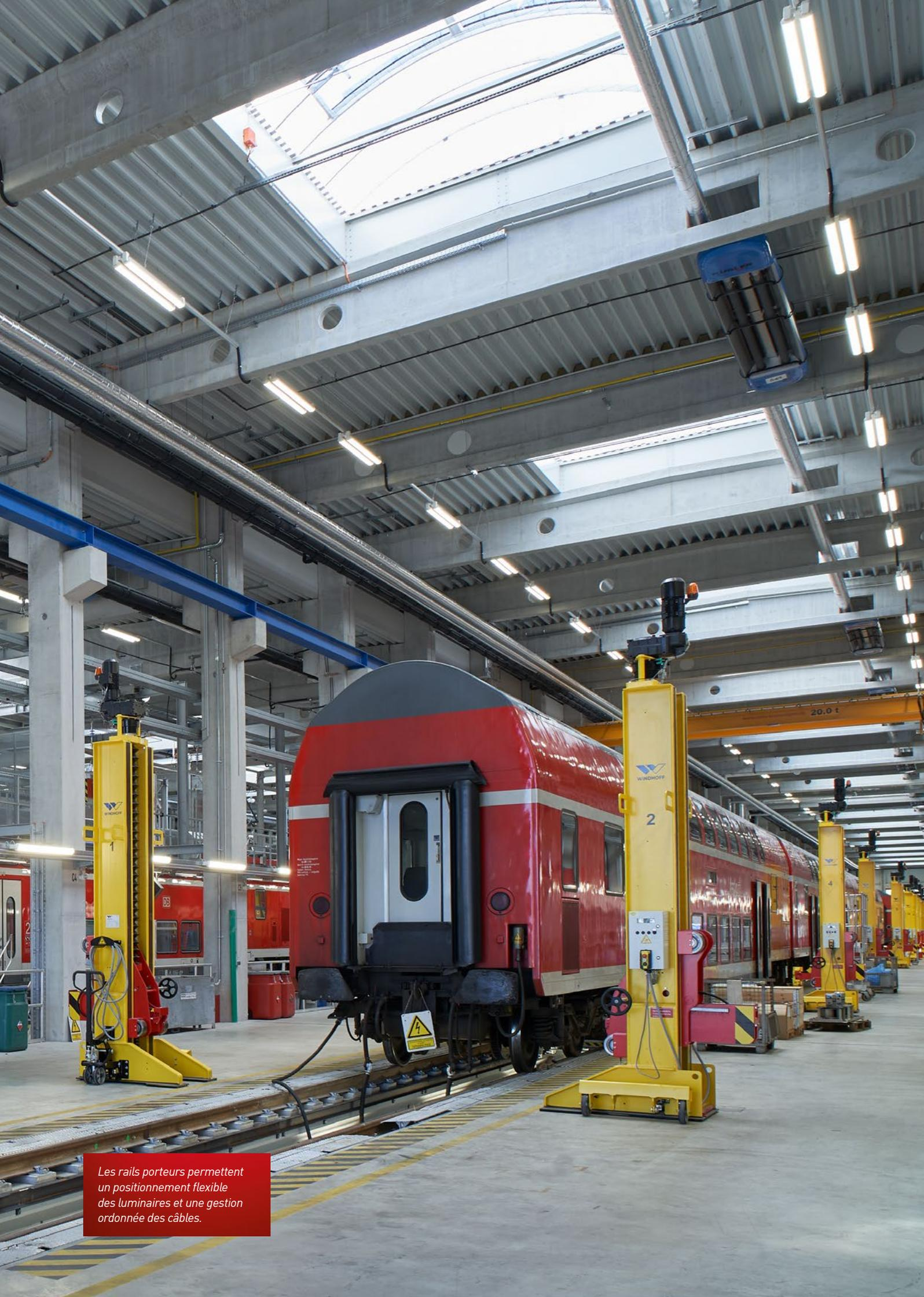
*Les rails porteurs permettent un positionnement flexible des luminaires et une gestion ordonnée des câbles.*
