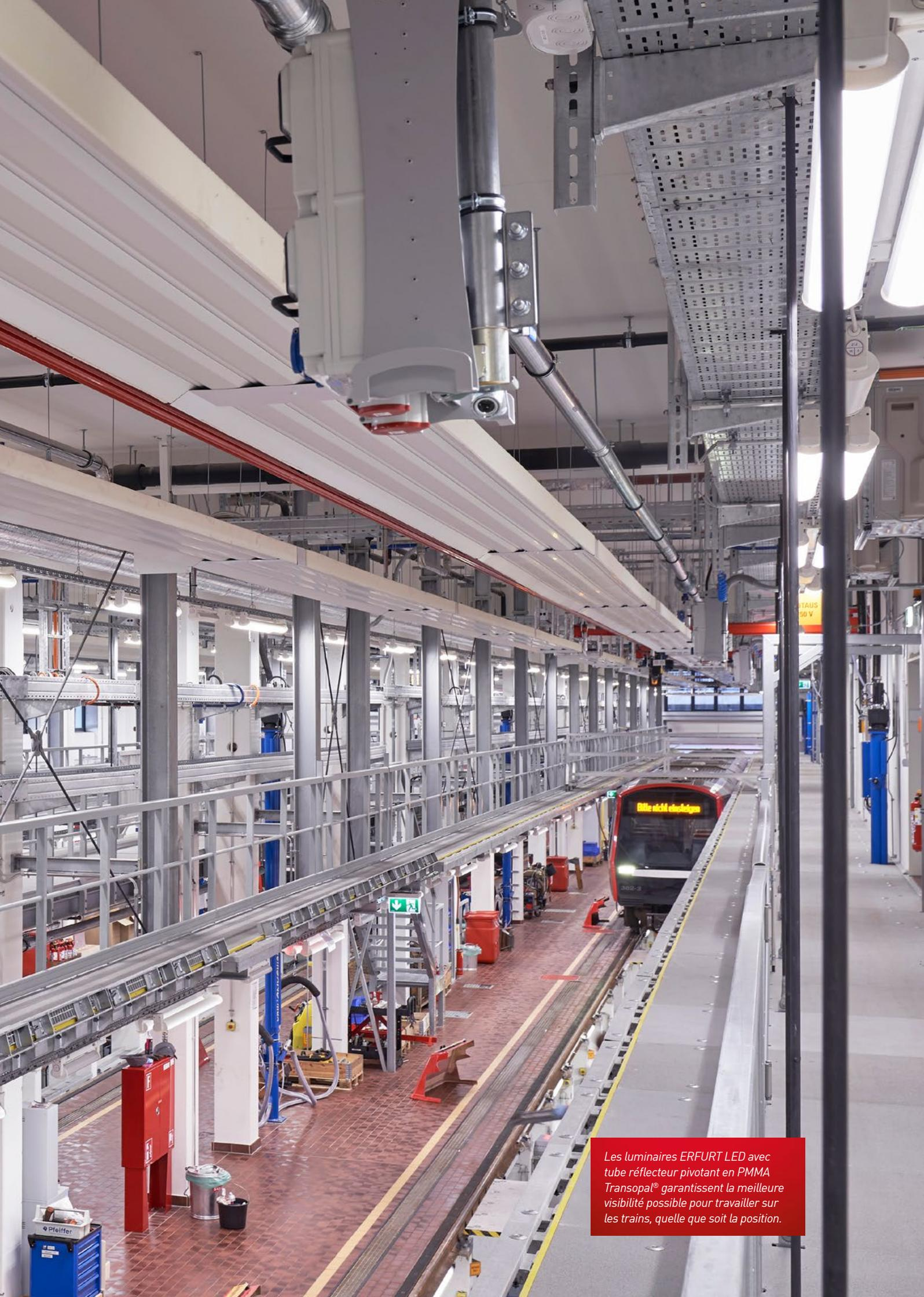
Les luminaires ERFURT LED avec tube réflecteur pivotant en PMMA Transopal® garantissent la meilleure visibilité possible pour travailler sur les trains, quelle que soit la position.
