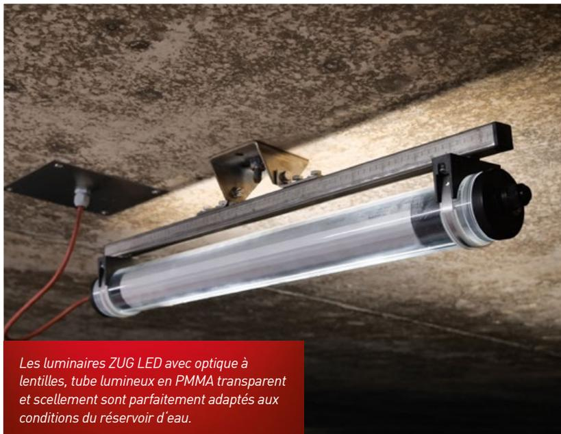
*Les luminaires ZUG LED avec optique à lentilles, tube lumineux en PMMA transparent et scellement sont parfaitement adaptés aux conditions du réservoir d'eau.*
