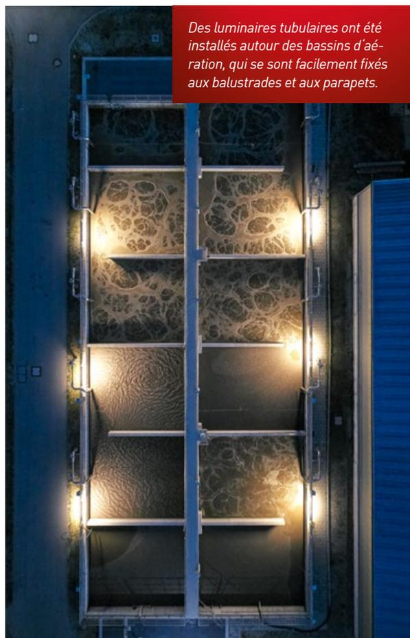
*Des luminaires tubulaires ont été installés autour des bassins d'aération, qui se sont facilement fixés aux balustrades et aux parapets.*
