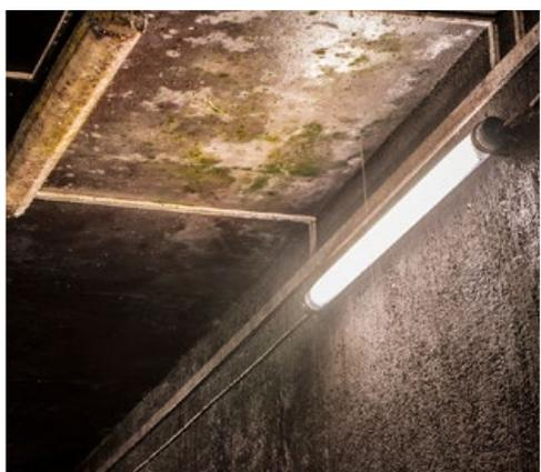
Ce sont des défis que tous les luminaires préalablement installés n'ont pas réussi à relever. Les tentatives répétées de réparation ne pouvaient remédier à la situation que sur de courtes périodes. Les luminaires se fragilisaient, l'eau s'infiltrait et il fallait les réparer une à deux fois par mois. Les coûts de maintenance étaient conséquents.
